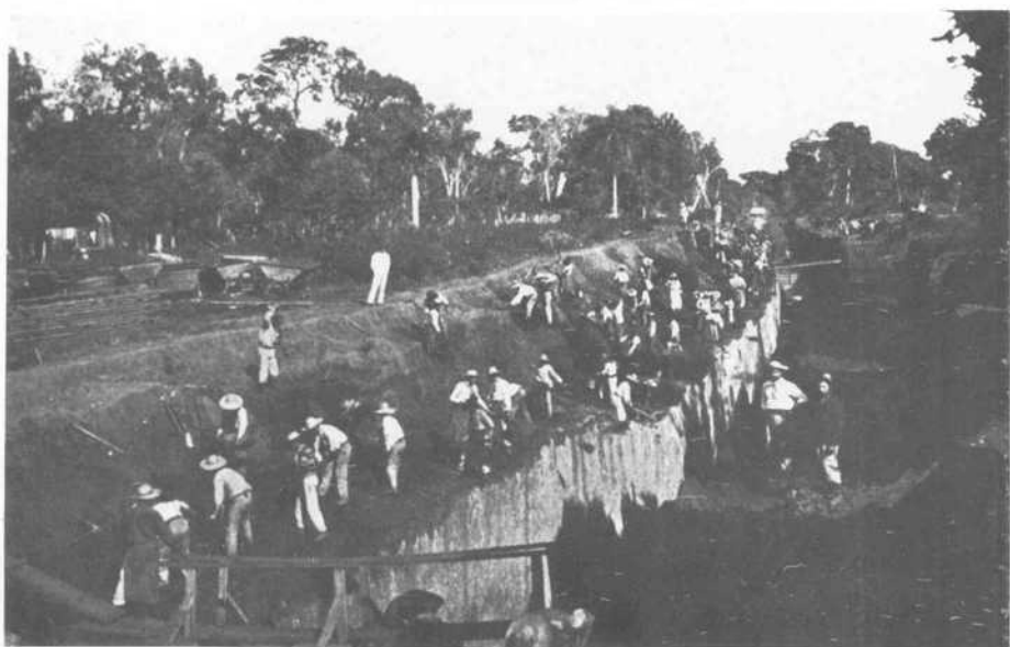
TENDIENDO VIAS DEL FERROCARRIL EN PIRAPO (Macdonald, 1911)
